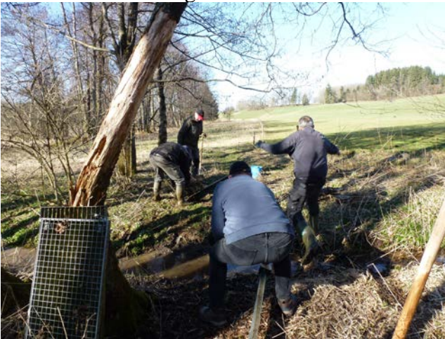
Die Brücke wird umgesetzt
