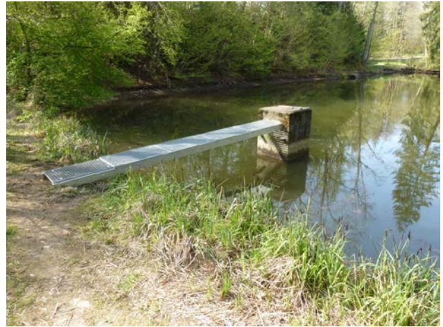
Der fault nicht mehr durch!
