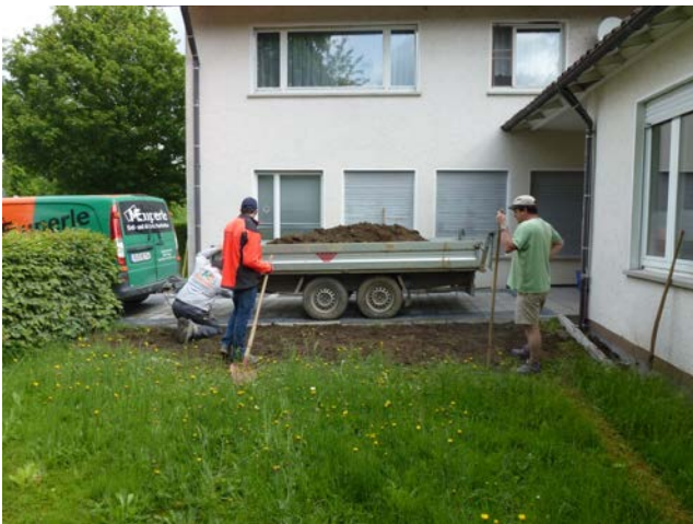
Adi und Hans vor den Humusarbeiten.
