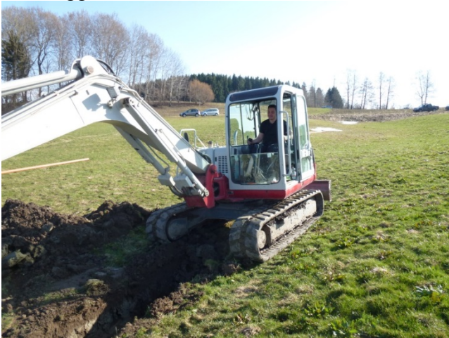
Der Bagger zieht den Graben.
