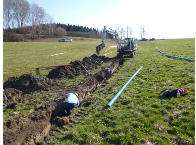
Dieter u. Sigi verlegen die neuen Leitungen.
