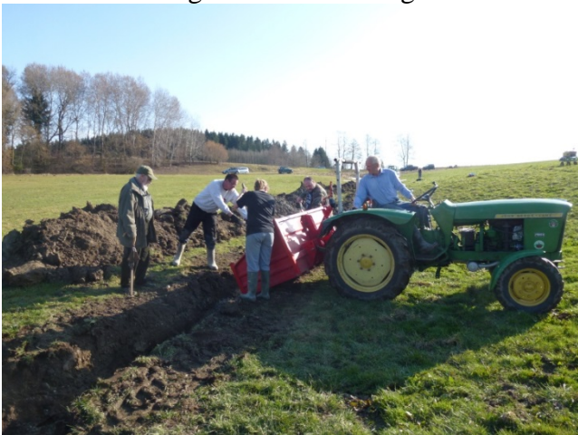
Das Einbringen der Rollierung durch Uli, Sabrina u. Günther erfolgt unter fachkundiger Aufsicht ☺
