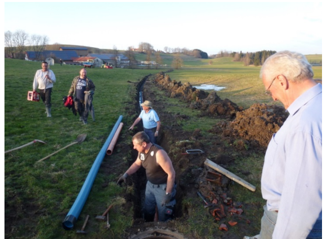
Die letzten Meter Leitungen werden verlegt.
