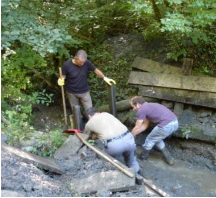
Manfred, Matthias und Sigi beim Vorbereiten des Bodens
